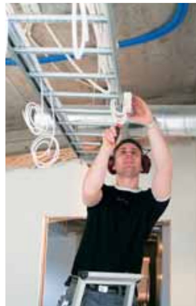
OPPDRAK FOR KOMMUNEN: Då Voss ungdomsskule vart bygd på 60-talet, hadde M.O. Mølster elektroarbeidet. Når ein av bygningane no vert renoverert meir enn 40 år seinare, er dei tilbake på same plassen. Her er montør Bjarne Djønnen i full sving.
